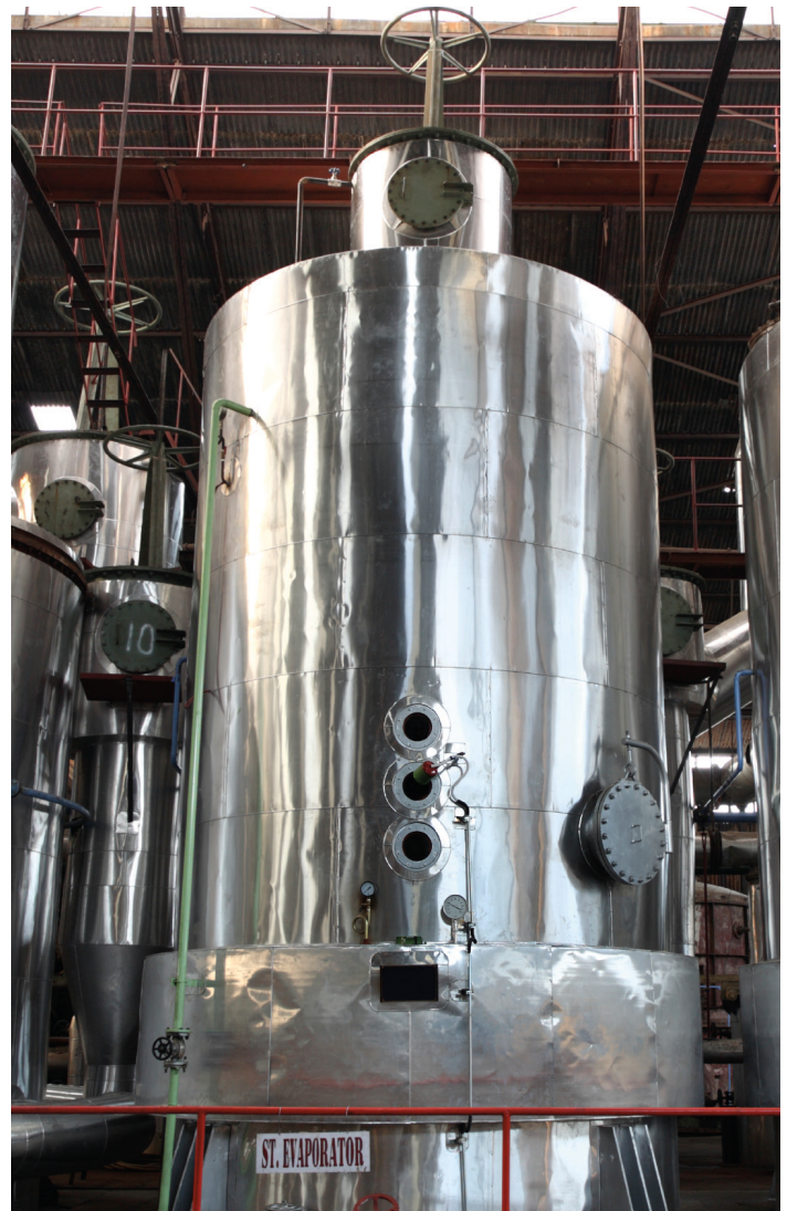
La flexibilidad de las Mantas Industriales de Thermafiber® facilita que sea sencillo de instalarlas en superficies cilíndricas como boilers, tanques, ductos y tubería de grandes diámetros.
